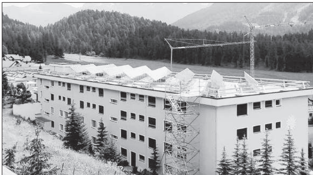
Depuis le 24 juin, l'hôtel Europa, à Saint-Moritz, possède la plus grande installation solaire de l'hôtellerie suisse. KEYSTONE
